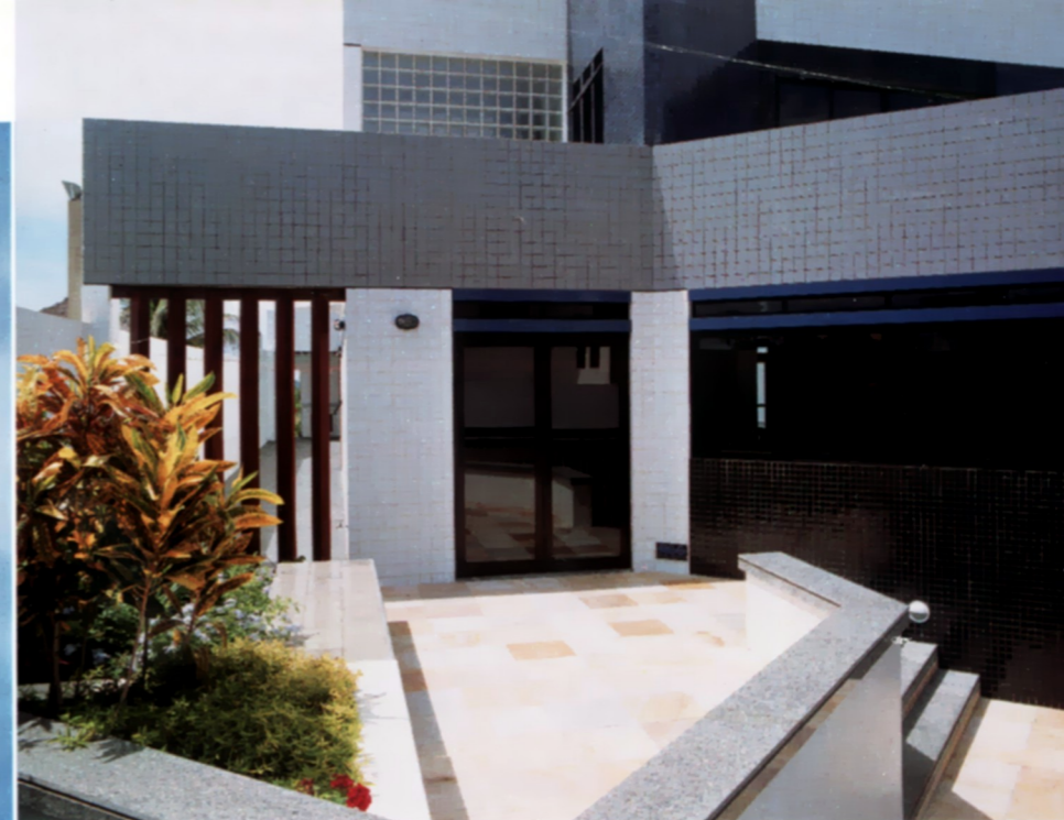
A torre da caixa d'água, revestida de pastilhas cerâmicas, marca a fachada onde se destaca ainda o portão da garagem, em madeira. A entrada social, ao lado, tem esquadrias em alumínio anodizado na cor preta e vidro fumê. Linhas retas em ângulos pontiagudos definem o estilo da construção.
