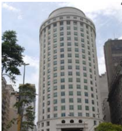
2. Edifício Serrador - RJ
