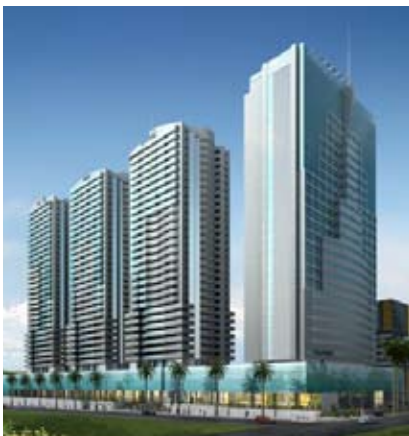
1. Edifício Salvador Prime - BA
