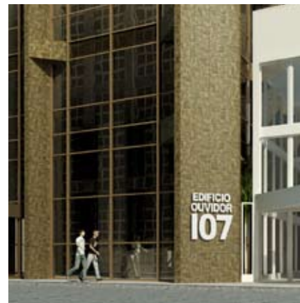
3. Edifício Ouvidor - RJ
